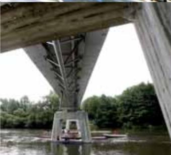
Die am 11. Juli eingeweihte Gärtnerplatzbrücke in Kassel ist die derzeit innovativste Brücke der Welt. Sie wurde mit einem in Kassel entwickelten ultra-hochfesten Beton hergestellt und die Betonbauteile wurden weltweit erstmals miteinander verklebt. Die Brücke ist ein Ergebnis der Kasseler Forschung und wird auch weiterhin Forschungsgegenstand sein. Geadelt wurde das Projekt, indem es zu einem „Ort im Land der Ideen“ erklärt wurde.
