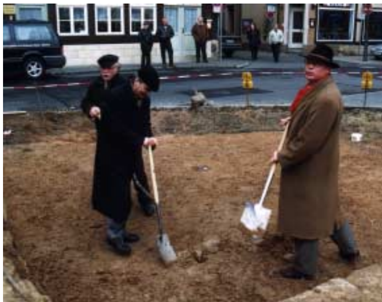
Am 1.3.1999 war es soweit - mit dem ersten feierlichen Spatenstich begannen die Bauarbeiten für das Projekt ‚Wasserspuren‘.
