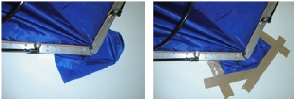
Bild 47: Abdichtungen der Eckbereiche mit Klebeband.
