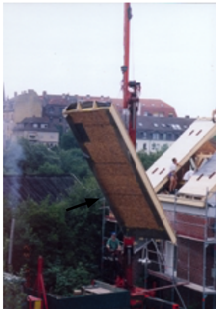
Bild 7: Die temporäre Befestigung der überstehenden Folie für den Transport und die Montage ist mit einem Pfeil gekennzeichnet.
