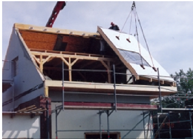
Bild 2: Montage des neuen Daches auf dem vorhandenen Versuchsgebäude.
