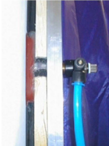
Bild 46: Die Vakuumsauger sind in die Dichtebene integriert.
