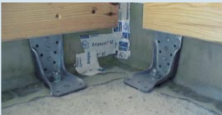
Beispiel eines sehr gut durchdachten und ausgeführten Anschlusses Außen-/Außenwand inkl. Anker: Hier wurde die Folie von beiden Wänden bis auf den Betonboden sowie unter die Anker gezogen und dort verklebt. Insbesondere die Überlappung der Folien im Eckbereich ist sauber verarbeitet
