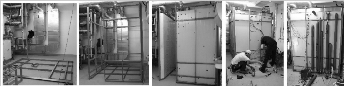
Errichtung eines FLEXSAVE Vario (5700 Liter Speichervolumen) beim Kunden. Der verfügbare Bauraum wird optimal ausgenutzt. Aufbauzeit: Etwa 1 Arbeitstag.
