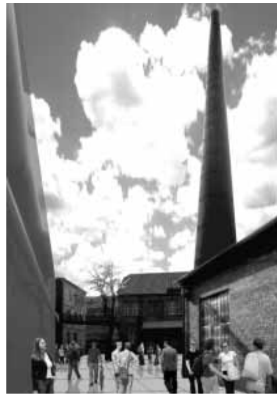
Der Schornstein als symbolträchtiges Element: charakterisierendes Erkennungsmerkmal des alten und des neuen Campus'. Fotomontage aus „Reflexionen zum Gottschalk-Gelände“.
