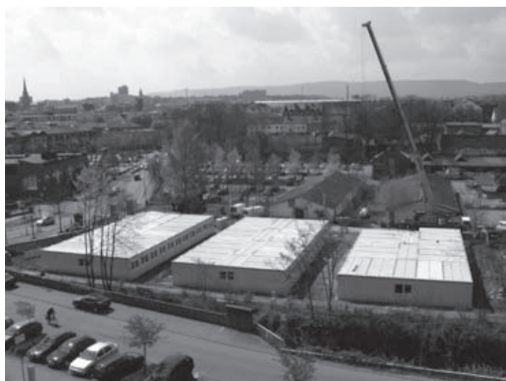
Blick auf eine von mehreren Unibaustellen: Noch im Mai sollen die Containerbauten bezugsfertig sein. Foto: Machill
