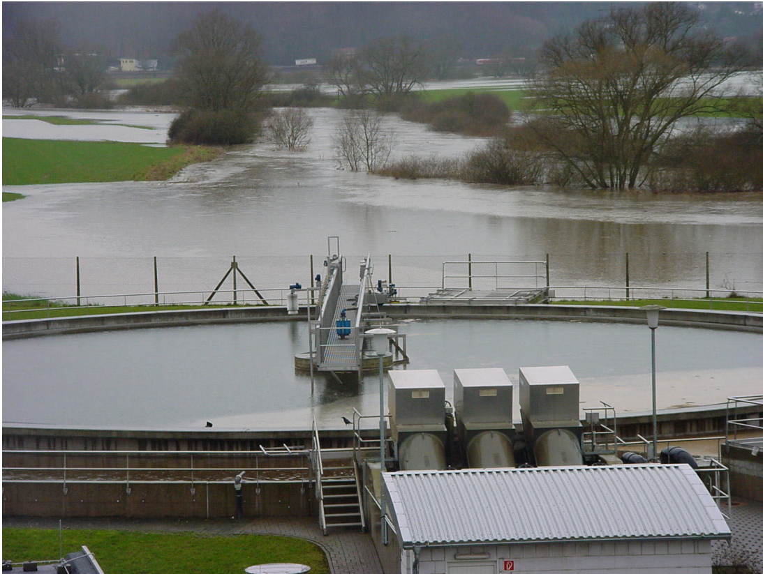
Abbildung 17: ertüchtigtes Nachklärbecken der Kläranlage Burgsolms (im Hintergrund: Retentionsraum der Lahn bei Hochwasser)
