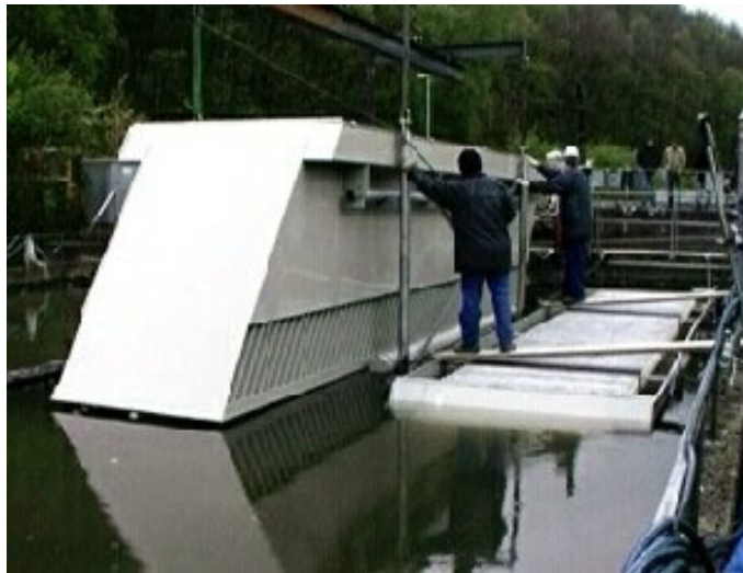
Abbildung 3: Einbau eines Lamellenabscheiders
