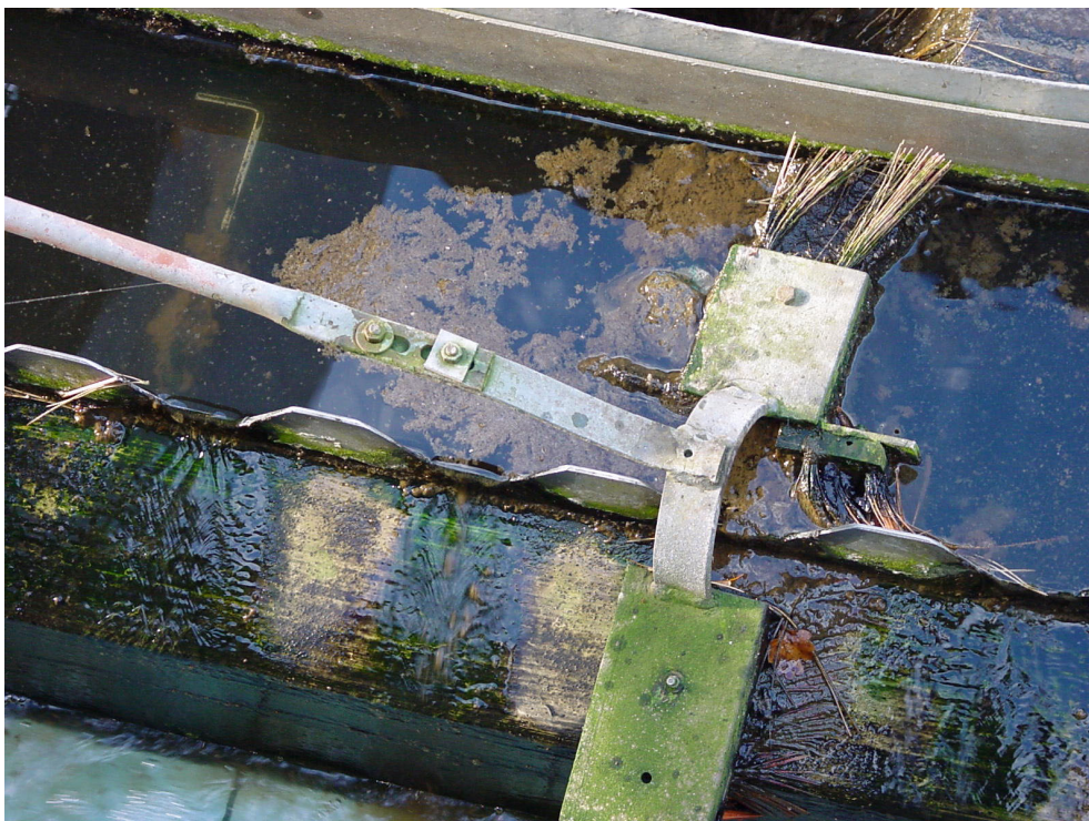
Abbildung 33: Schlammabtrieb im vorhandenen Nachklärbecken
