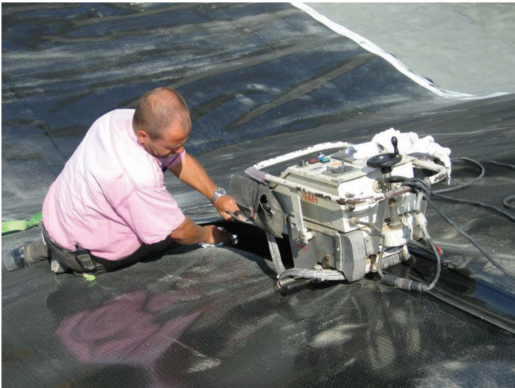
Abbildung 6: Verlegen und Verschweißen von Kunststoff-Dichtungsbahnen
