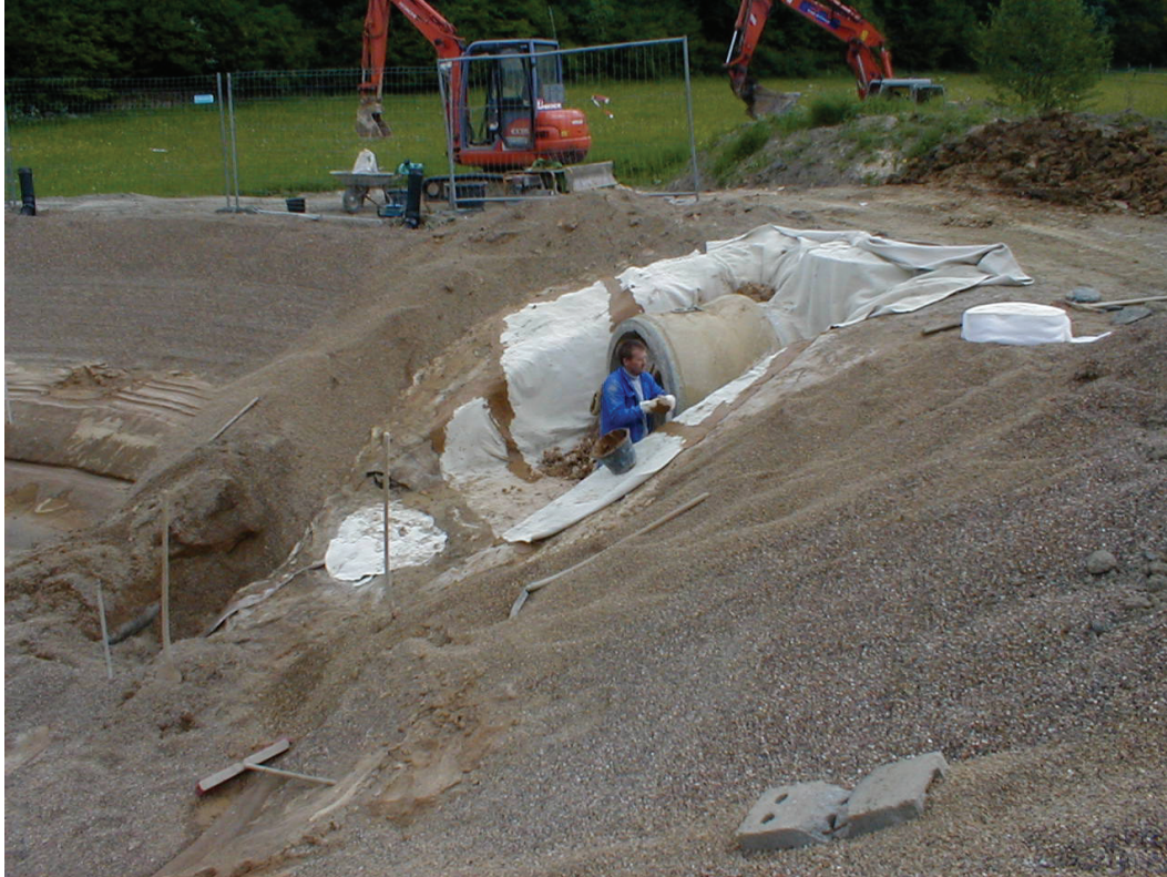
Abbildung 7: Nachbesserung Basisabdichtung
