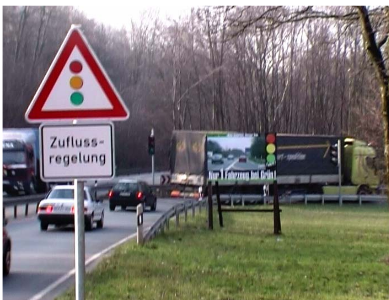
Abbildung 12: Zuflussregelung an Autobahnzufahrten
