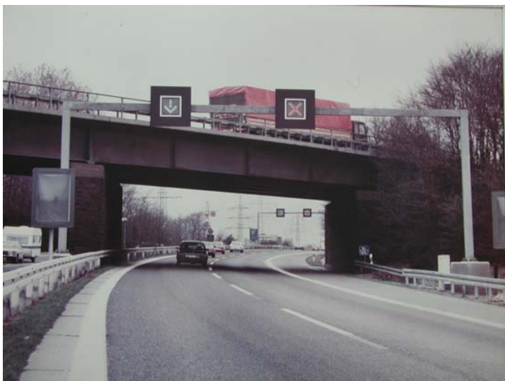
Abbildung 5: Fahrstreifensignalanlage am AD Heumar
