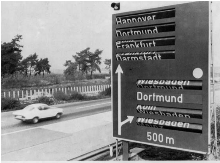
Abbildung 3: Wechselwegweisungs- anlage im Rhein-Main-Gebiet
