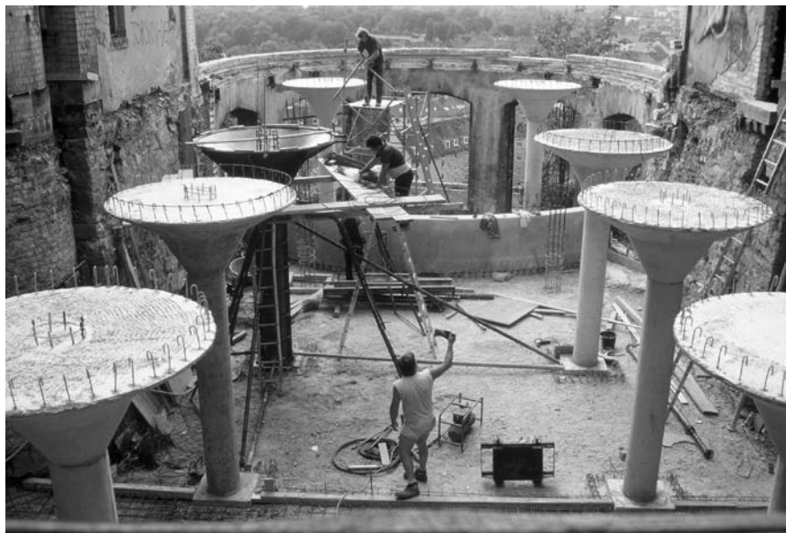
Die durch Ausschachtung des Innenhofs des Altbaus gewonnene „Säulenhalle“ des Museums vor der Eindeckung.
