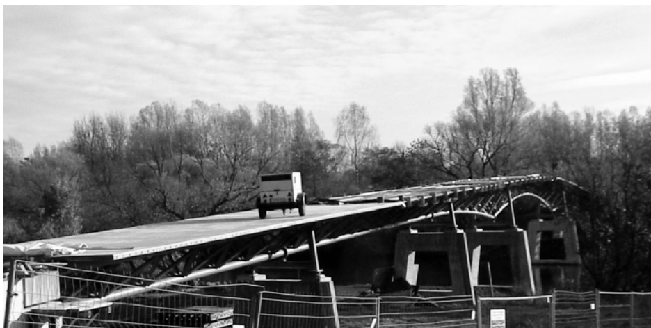
Abb. 1: Fertigteile aus Ultra-Hochfestem Beton für das Brückendeck der Gärtnerplatzbrücke in Kassel (Quelle Universität Kassel)
