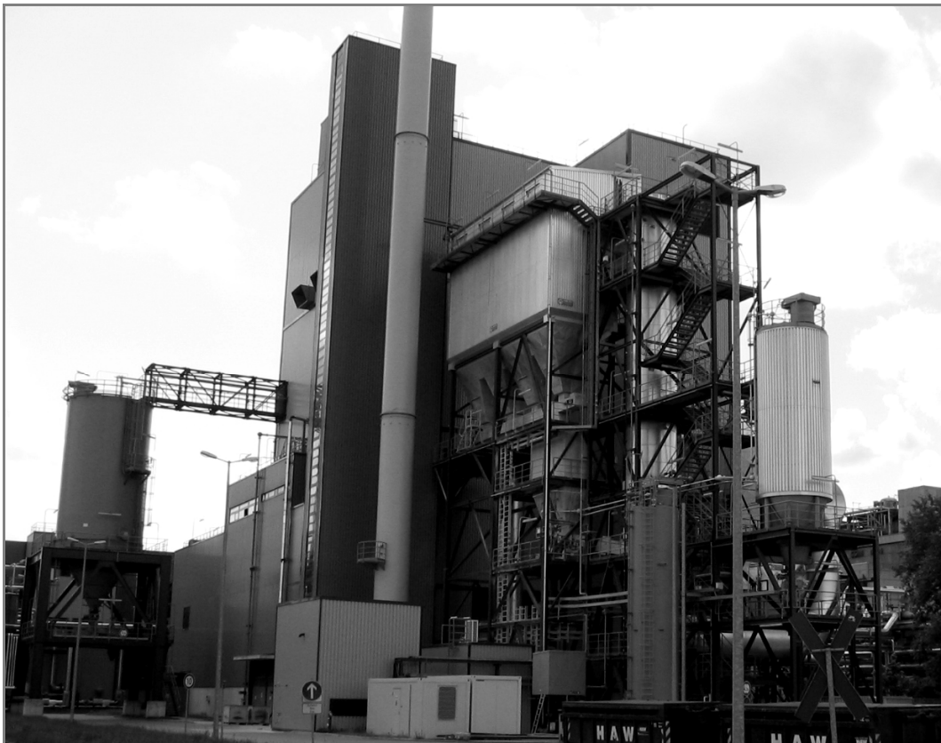
Abbildung 2: Rauchgasreinigungsanlagen der ZWSF Premnitz
