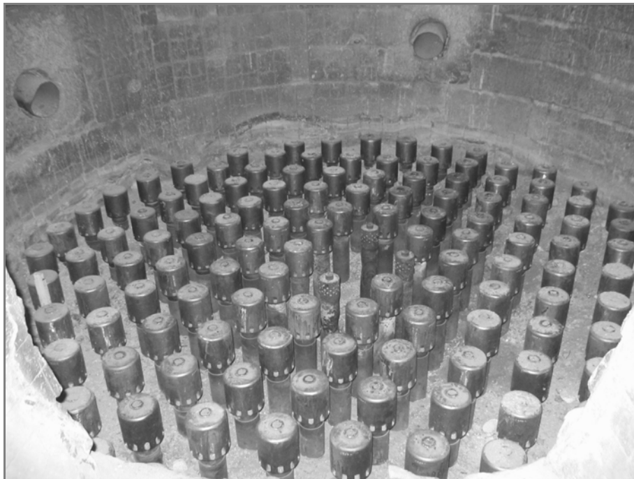
Abbildung 5: Düsenboden mit zentralem Ascheabzugsrohr, darüber Einblasstellen für Ersatzbrennstoffe
