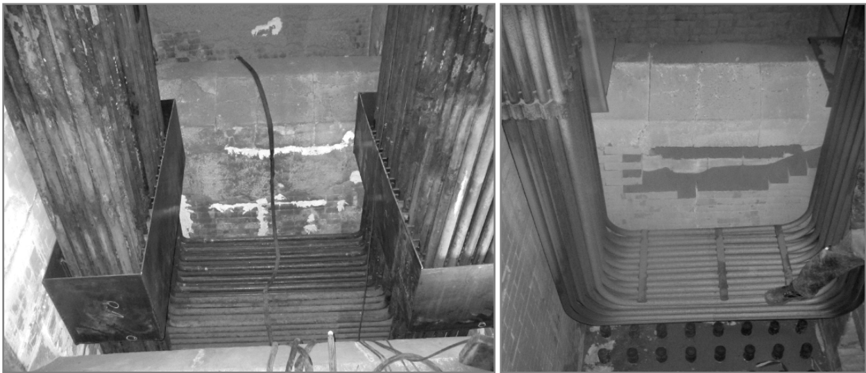
Abbildung 9: Überhitzer 3 und 4 während des Einbaus (links) und modifizierte Heizfläche im Überhitzer 3 (rechts)
