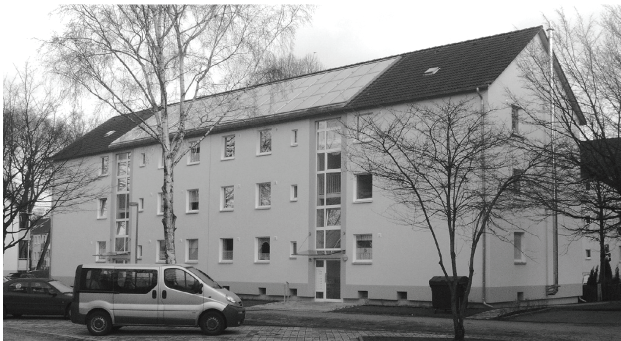
Abbildung 3.9: Foto des 90 m 2 großen Solar-Roofs der Betreiberanlage in Gelsenkirchen.
