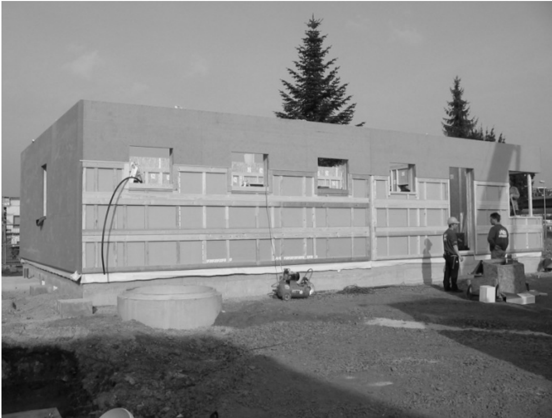
Bild 19: Holzskelettbauweise (außen)
