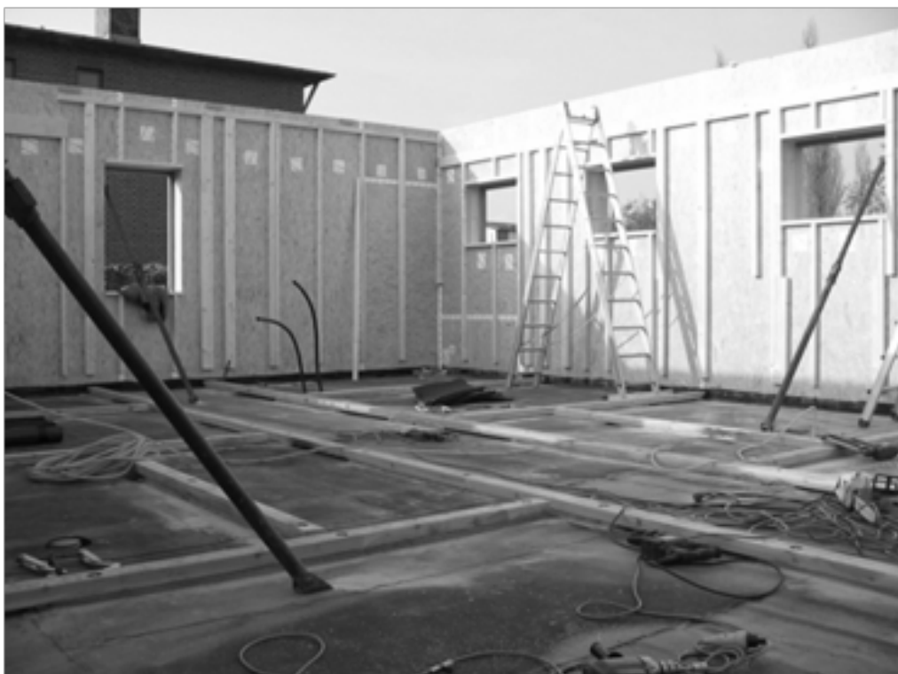
Bild 18: Holzskelettbauweise (innen)
