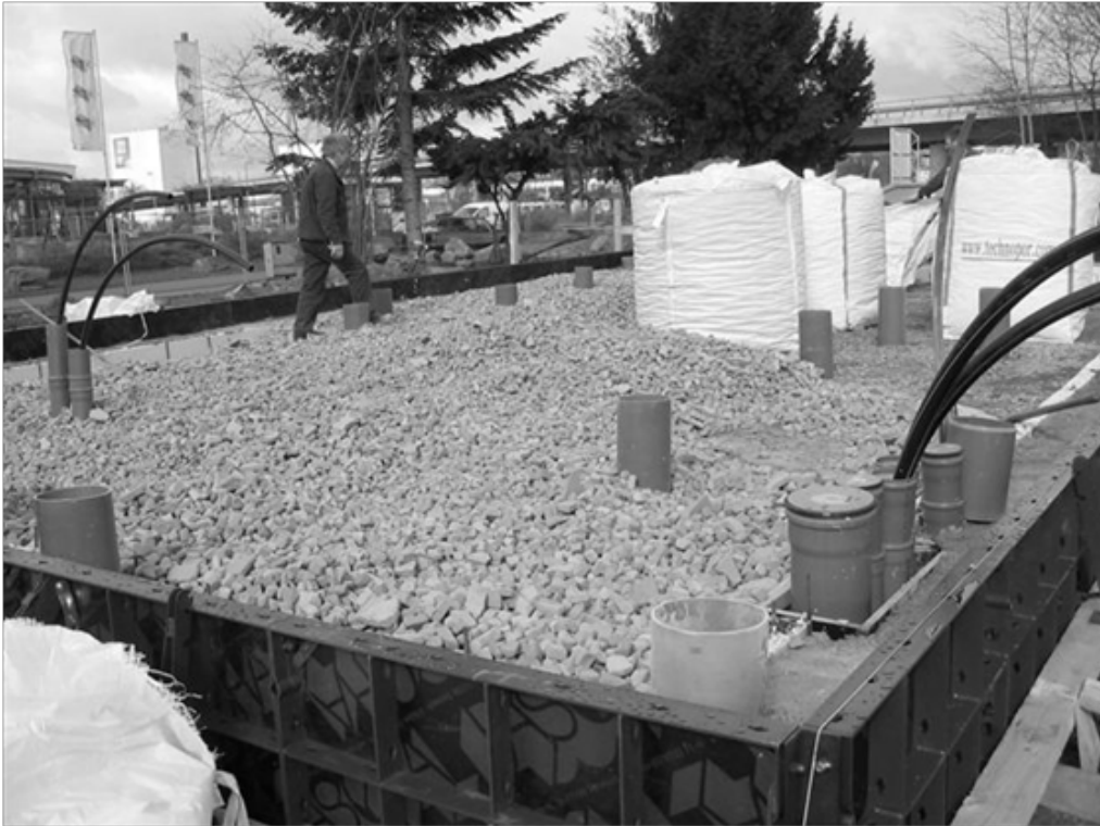
Bild 17: Glasschaumschotterdämmung
