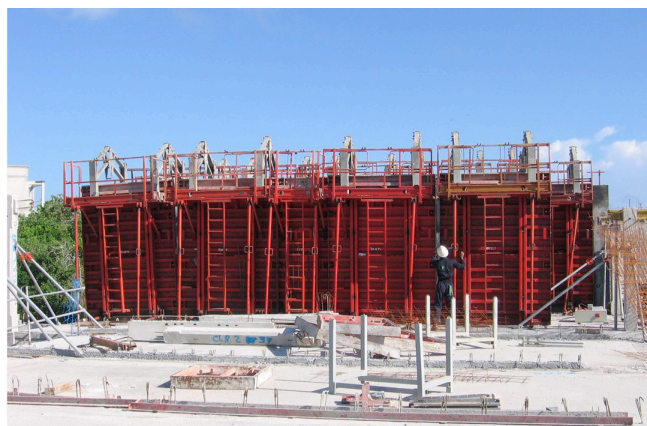
75 Moldes metálicos para estructuras de hormigón
