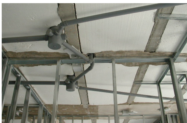
74 Bovedilla de poliestireno expandido en entresijos
