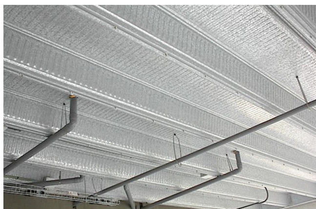
76 Planchas galvanizadas Deck para entrepisos y cubiertas
