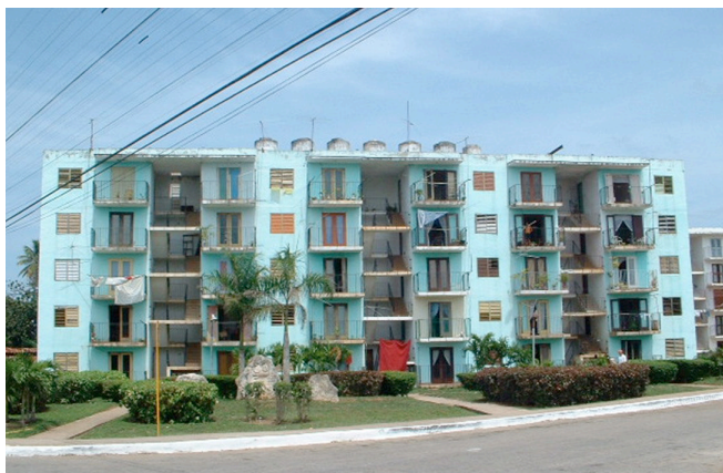
50 Edificio de viviendas, Gran Panel VI, Remedios
