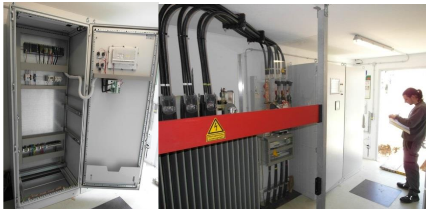
Abbildung 6.11: Schaltschrank mit der entwickelten Regelungs- und Betriebsführungseinheit des Fraunhofer IWES (links) und Innenansicht mit integriertem Schaltschrank in der Ortsnetzstation in Felsberg-Niedervorschütz (rechts).
