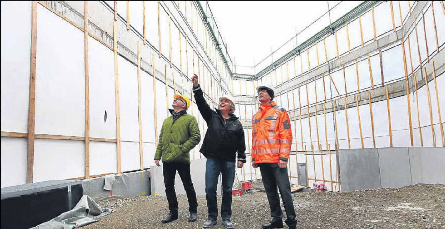
Im Innenhof: Die Science-Park-Geschäftsführer Gerold Kreuter (links) und Dr. Oliver Fromm (rechts) überzeugten sich gestern mit Bauleiterin Corinna Wilhelmi vom Baufortschritt. Noch sind die Fassaden mit Kunststoffplatten verkleidet, um die Wärme im Innern des Gebäudes zu halten. Im Frühjahr soll die Glasfassade angebracht werden.
