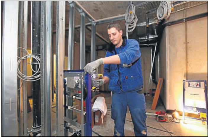
Innenausbau in vollem Gange: Ingo Vossen von der Firma Leniger (Paderborn) montiert die Unterputzgestelle in den Toiletten.
