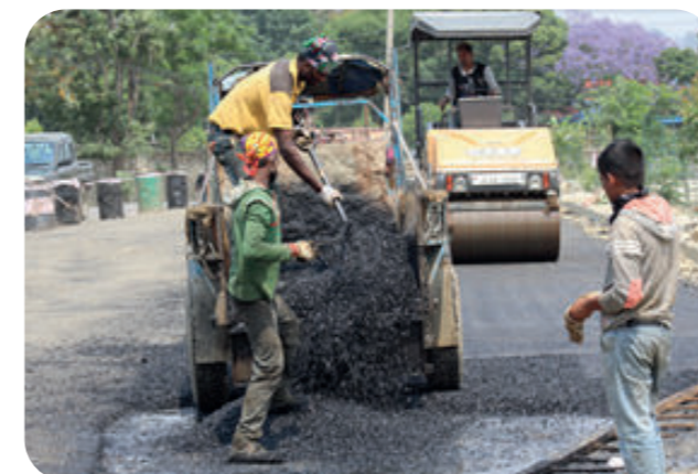
Einbau kunststoffmodifizierter Asphalte in Nepal (links) und Potsdam (rechts)
