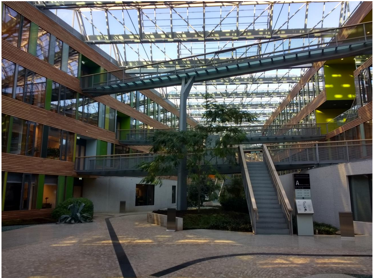
3 Blick auf die Brücken, die die zwei Bürogebäudeteile verbinden, Foto des Autors
