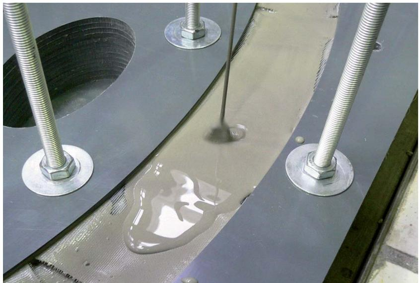
Betonage mit selbstverdichtendem Beton mit einer von den Ingenieuren entwickelten Spezialrezeptur
