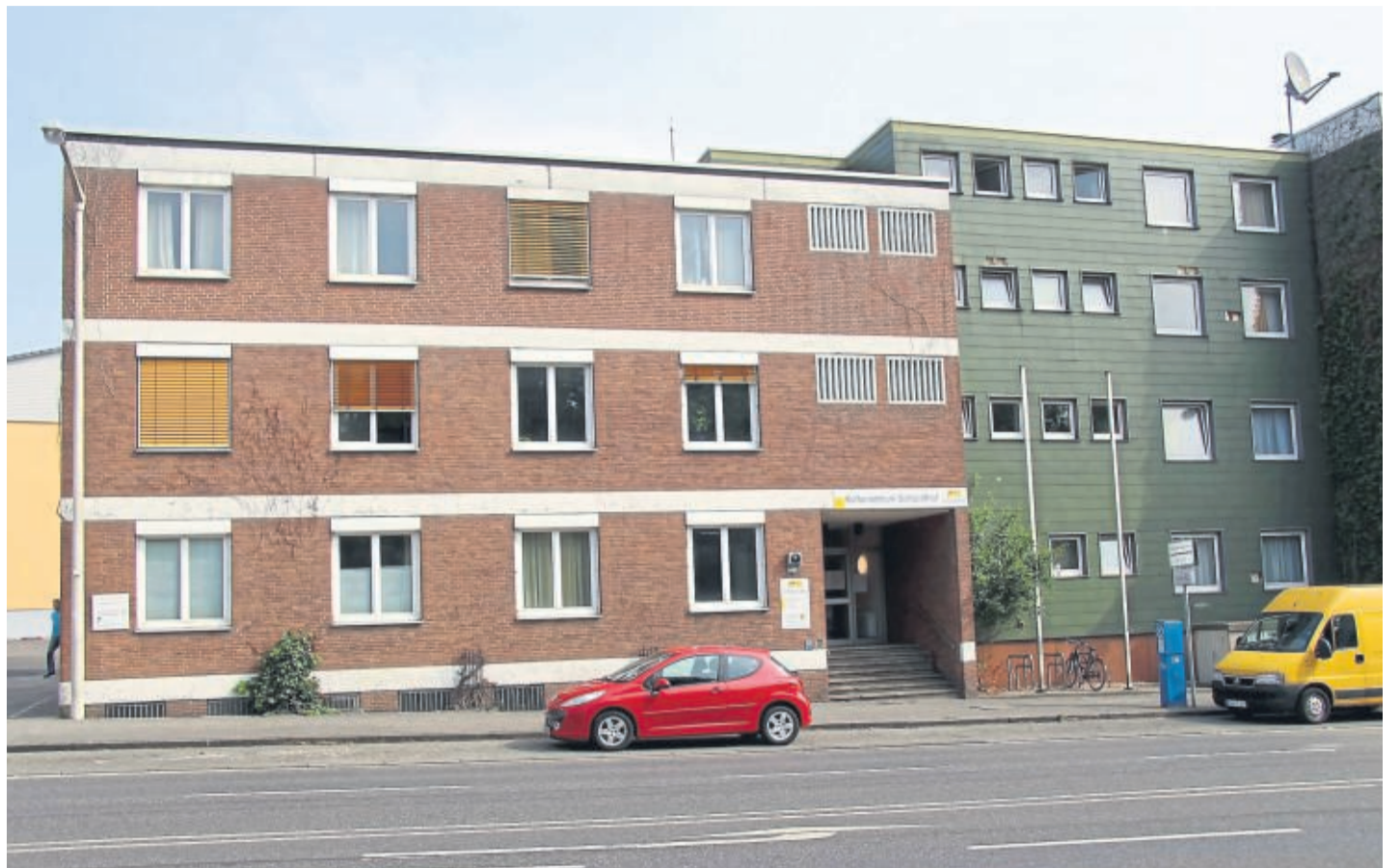
Soll erweitert und saniert werden: Die Gebäude an der Wolfhager Straße 10 sollen umgebaut werden. Der linke Gebäudeteil wird zu dem aufgestockt. So werden 30 neue Wohnheimplätze entstehen.
