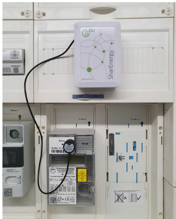
Abbildung 63: Blockchainfähige Hardware (OLI-Box) und Smart Meter in einem Zählerschrank zur Teilnahme am lokalen Energiemarkt WIRcommunity.
