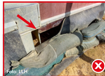
Durch solche kleinen Löcher können Schadnager in den Stall eindringen.
