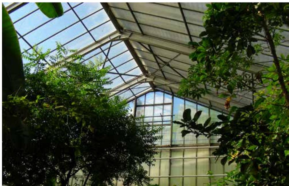
Das Palmenhaus während der Baumaßnahmen. Im Dachbereich links oben die erneuerte, rechts oben die alte Eindeckung
