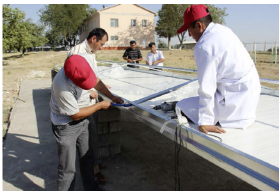
Aufbau eines Solar-Tunnel-trockners an der Kensoy Fachschule in Taschkent, Usbekistan
