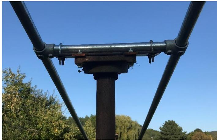
Abbildung 11: Lagerung Drehpunkt
