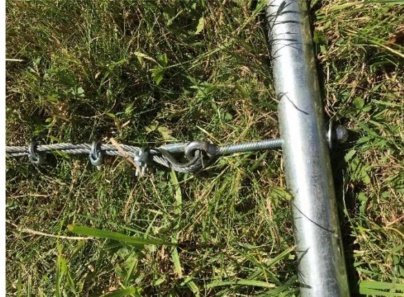
Abbildung 8: Nachspannvorrichtung
