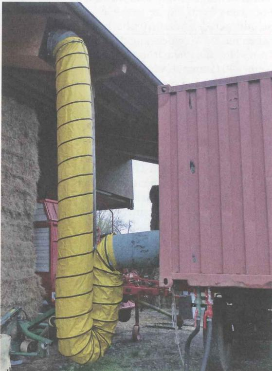
Von der Hackschnitzelanlage des Betriebes Oberfeld wird heißes Wasser in einen Wärmetauscher geleitet und damit Luft erhitzt. Diese wird dann zum Trocknen des Heus in die Kammer geblasen.
