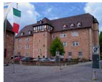
Bild 1: Behördenhaus Melsungen (BHH)
