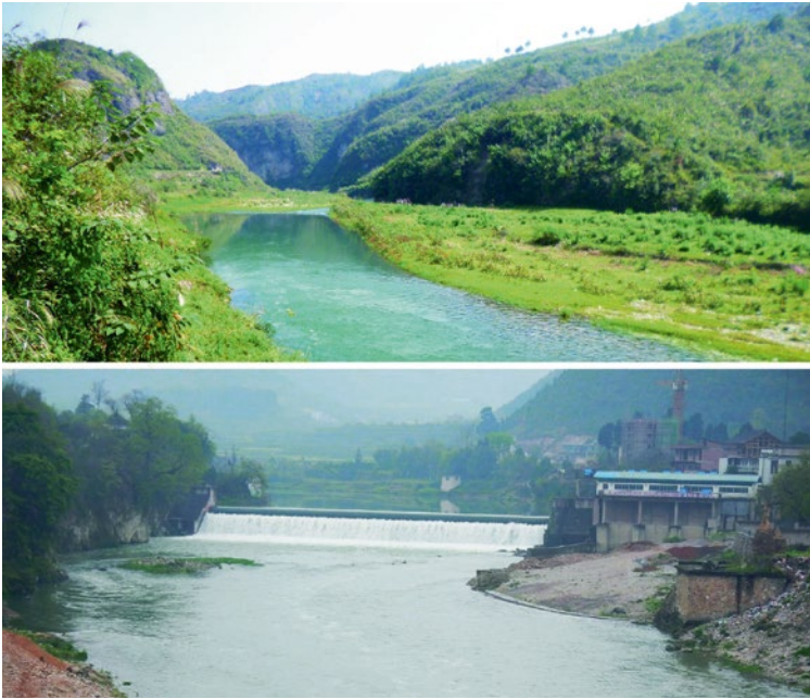
Bild 3: Sperrenstandorte von beispielhaft bearbeiteten Wasserkraftstandorten: oben: geplanter Standort YinDiBa (Blick stromab); unten: Bestandskraftwerk Fujjiang (Blick stromauf)
