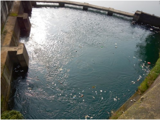
Bild 5: Zulaufbereich der bestehenden Wasserkraftanlage Fujiang (vom linken Ufer aus gesehen)
