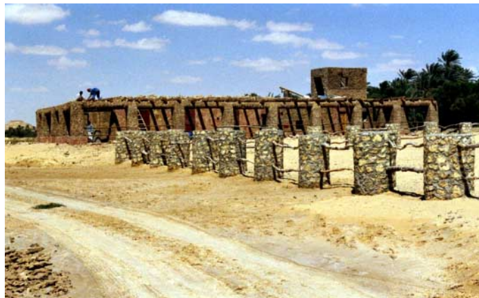
im Bau befindliche Pferdekoppel nahe der Eco-Lodge
