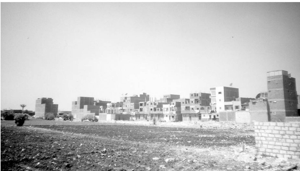
Neubauten auf ehemaligem Bewässerungsland am südlichen Stadtrand El Minias
