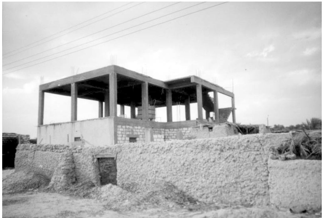
hinter Resten eines alten Siwaner Lehmgebäudes entsteht ein neues Haus in der heute bevorzugten Bauweise
