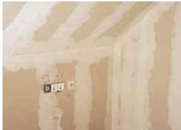
Bild 7 Abseiten/Giebelbereich eines Gebäudes
