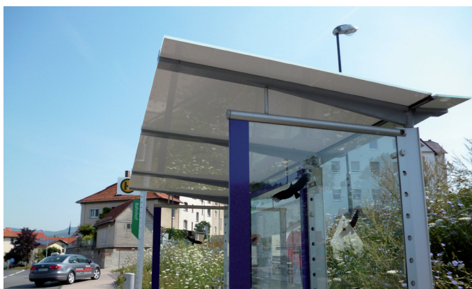
Mit weißer Sonnenschutzfolie nachgerüstete Bushaltestelle am Kreis Krankenhaus in Eschwege
