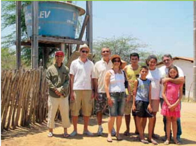
Besuch einer mit Solarstrom betriebenen Wasserentkeimungsanlage nahe Pentacosta Visiting a PV powered water treatment system in Pentacosta
