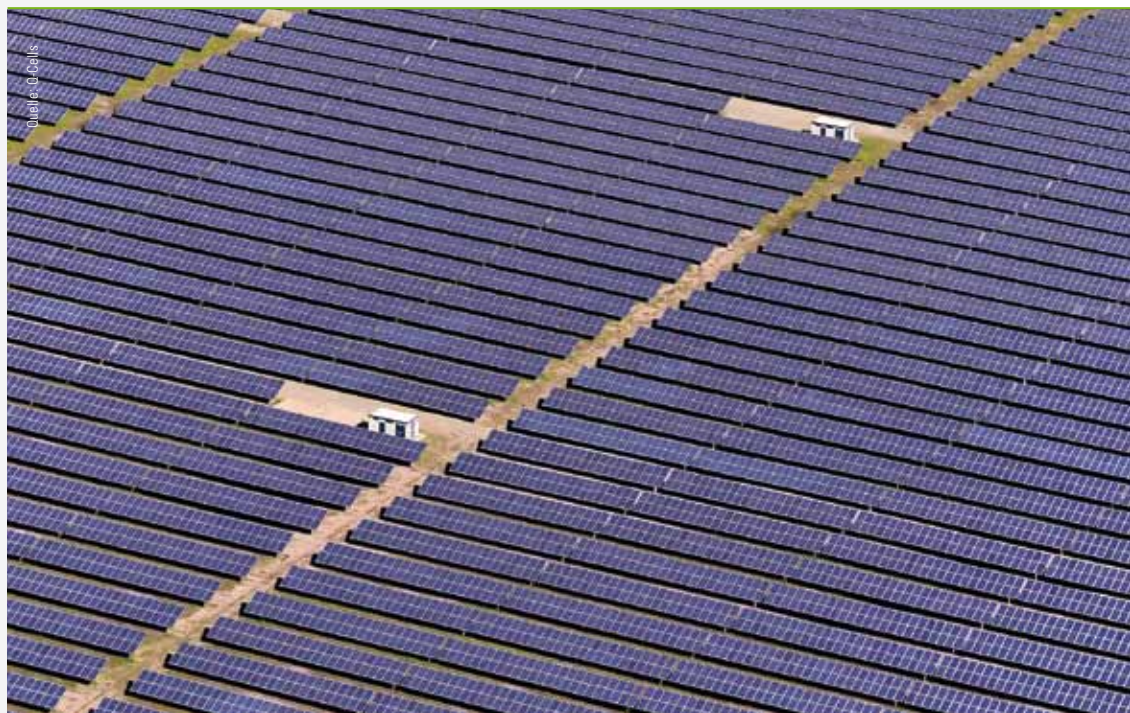
PV-Großkraftwerk Large-scale PV power plants
