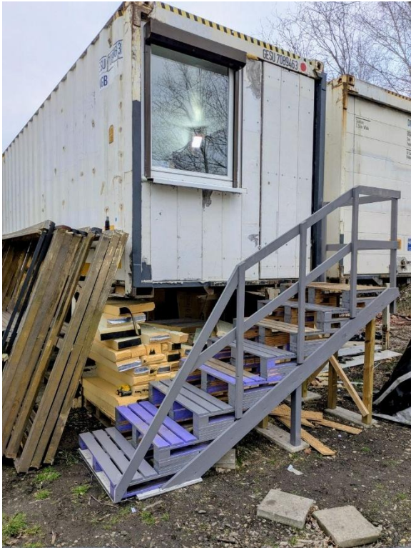
Abbildung 6 Eingang Wechselbrücken (NSt)
