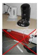
Bei der Benutzung von Mehrfachsteckdosen ist die maximal zulässige Leistung der Steckdose sowie der jeweilige Verwendungszweck zu beachten. Mehrere Mehrfachsteckdosen oder Verlängerungskabel dürfen nicht miteinander verbunden werden.
