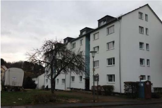
**Abbildung 4-6: Demonstrationsanlage MFH2, 33,8 m<sup>2</sup> Aperturfläche, 2 m<sup>3</sup> Solarspeicher, TWW-Unterstützung für 16 WE**
