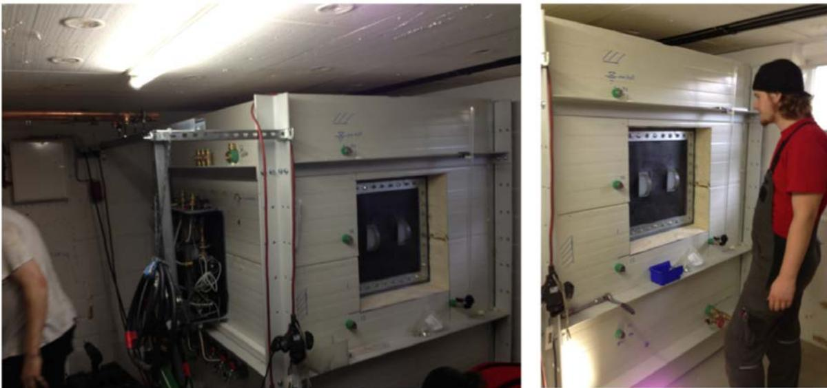
**Abbildung 4-3: Installation des kubischen 2 m<sup>3</sup> Solarspeichers im Keller von MFH1**
