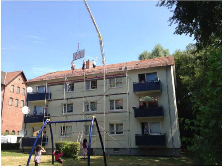
**Abbildung 4-2: Kollektorfeldinstallation MFH1**
