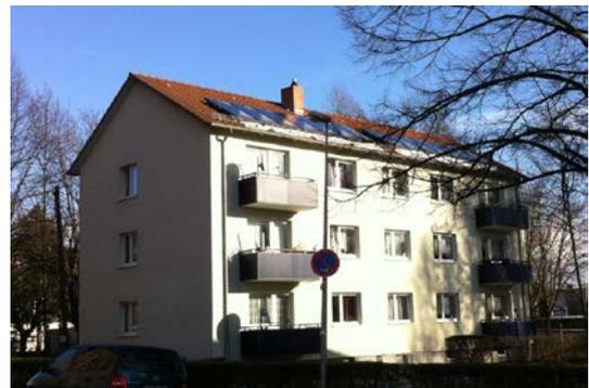
**Abbildung 4-5: Demonstrationsanlage MFH2,  $32,2 \text{ m}^2$  Aperturfläche,  $2 \text{ m}^3$  Solarspeicher, TWW-Unterstützung für 12 WE**
