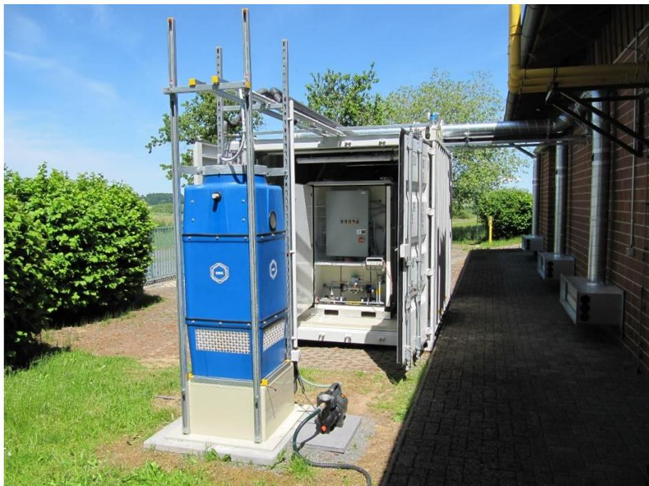
Abbildung 30: Blick auf den Kühlturm und in den Sorptionscontainer. Neben dem Kühlturm ist das Hauswasserwerk zu erkennen, welches den Kühlturm mit Zusatzwasser (Regenwasser) speist. Rechts im Bild sind die Zuluftrohre zum Ex-Schutzraum mit Lüftungsclappen zu sehen.
