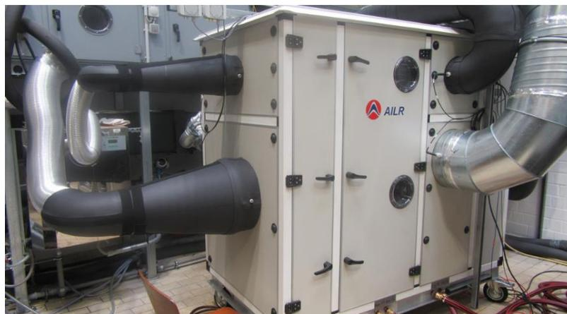
Abbildung 4: Foto der LDAC-Anlage, links im Bild Zuluftanschlüsse Regenerator (oben), Absorber (unten) und rechts im Bild die Abluft Regenerator (oben), Absorber (unten).
