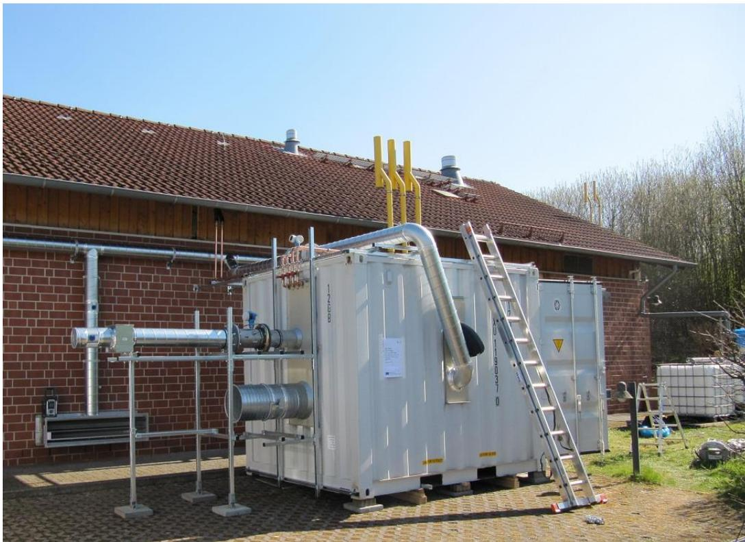
Abbildung 8: Die Aufnahme zeigt den Stand vor Ort bei der GDRA in Neu-Eichenberg am 06.04.2020. Der Sorptionscontainer befindet sich im Vordergrund und im Hintergrund das GDRA-Gebäude. Rechts im Bild sind die Regenwasserspeicher mit Anbindung an die Dachrinne des Gebäudes zu erkennen.
