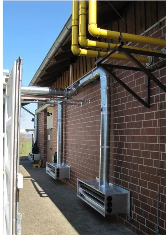
Abbildung 7: Zuluftrohre und Lüftungskappen des Zwangslüftungssystem. Über diese wird die trockene Zuluft in das Gebäude geführt.
