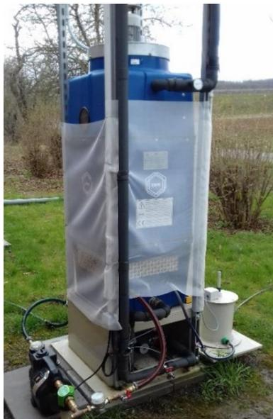
Abbildung 9: Das Foto zeigt den aufgebauten Kühlturm des Verdunstungskühlsystems mit Insektengitter auf dem Standort der GDRA Neu-Eichenberg.
