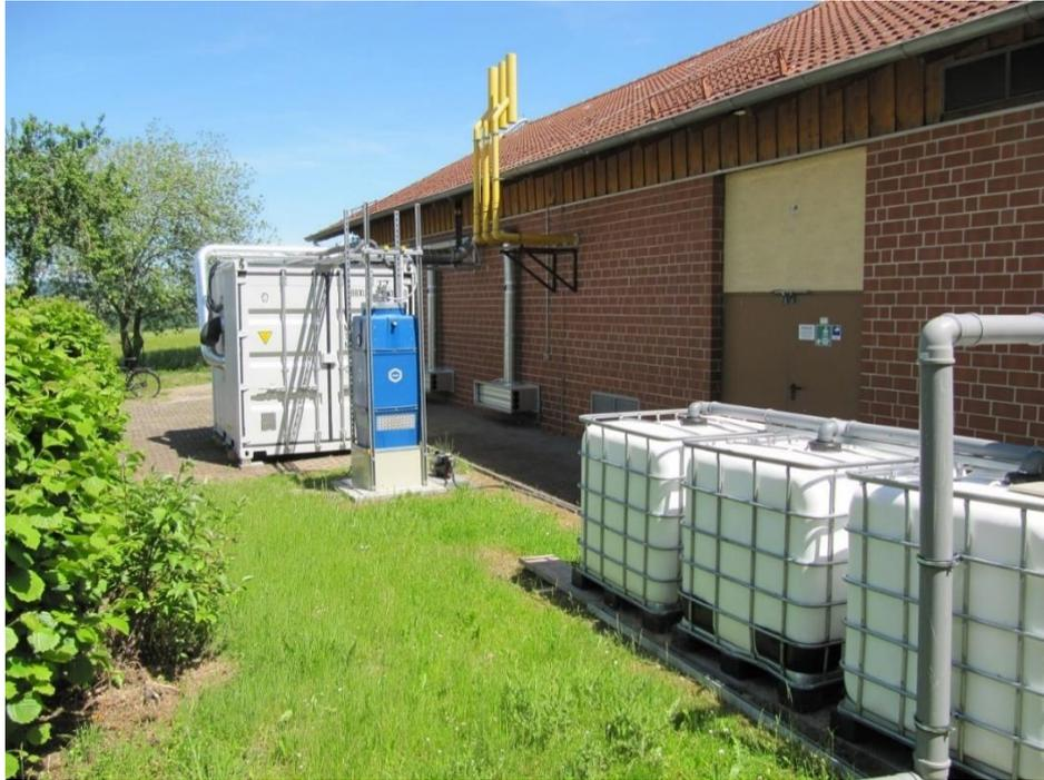
Abbildung 29: Das Foto zeigt das aufgebaute Gesamtsystem in Neu-Eichenberg. Der Sorptionscontainer zusammen mit dem Kühlturm befindet sich in Bildmitte und im Hintergrund das GDRA-Gebäude. Rechts im Bild sind die Regenwasserspeicher mit Anbindung an die Dachrinne des Gebäudes zu erkennen.
