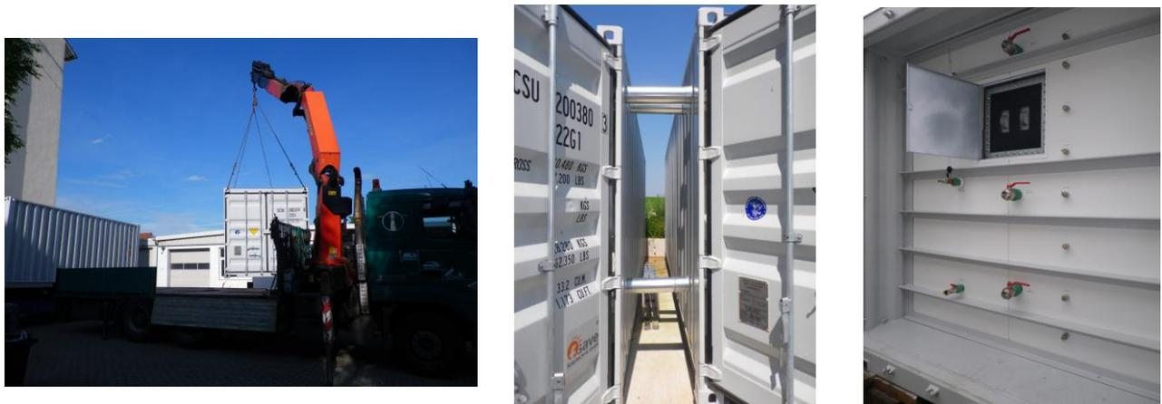
*Abbildung 5: Verladung eines Container-Speichers (links), Zusammenschaltung von zwei Container-Speichern (mitte), Frontansicht mit Revisionsöffnung (rechts)*
