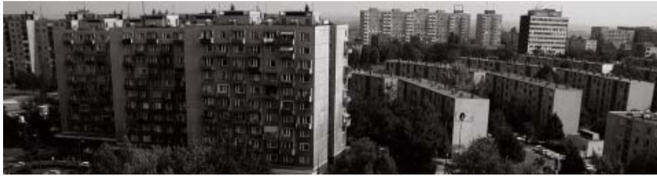
Ein Plattenbau lernt Energie sparen: Wohnsiedlung im ungarischen Dunaújváros. Foto: SOLANOVA
