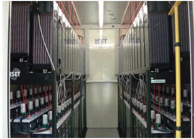
Abbildung 5.4: Batterieeinheit des Multi-PV-Systems (384 V, 800 Ah ( C_{10} ), 192 Zellen) vor der DeMoTec .
