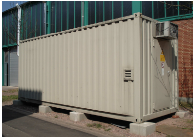
Abbildung 5.4: Batterieeinheit des Multi-PV-Systems (384 V, 800 Ah ( C_{10} ), 192 Zellen) vor der DeMoTec .
