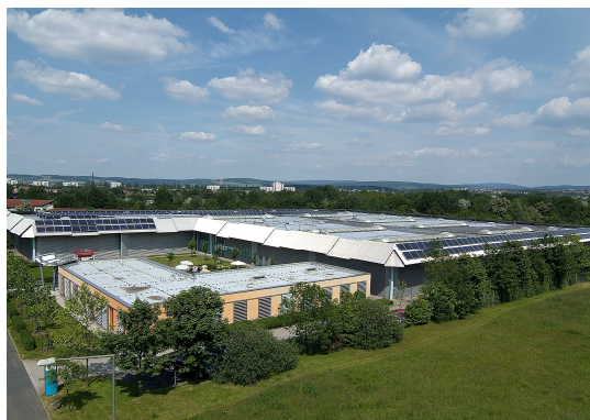
Abbildung 5.5: Werk 3 der Hübner GmbH mit der PV-Anlage von etwa 100 kW p für das Multi-PV-Prototypensystem.
