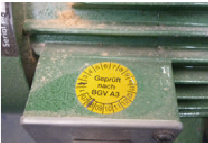
Abb. 18: Prüffristen der elektrischen Betriebsmittel erheblich überschritten
