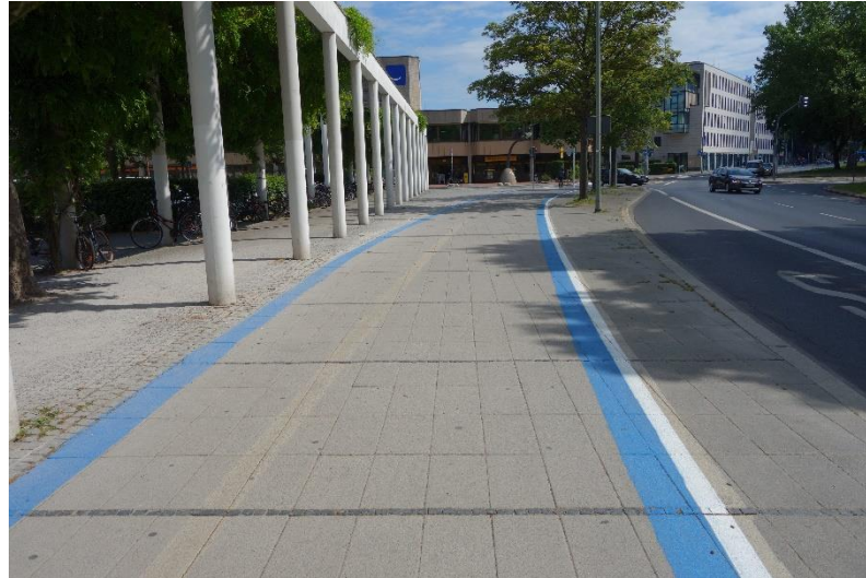
Abbildung 95: Neue (blau) und alte (blass gelb) Randstreifen zur Markierung des Radwegs
