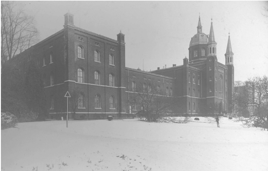
Abb. 1: Das Maria-Hilf-Hospital im Jahr 1914, kurz vor seinem Abriss
