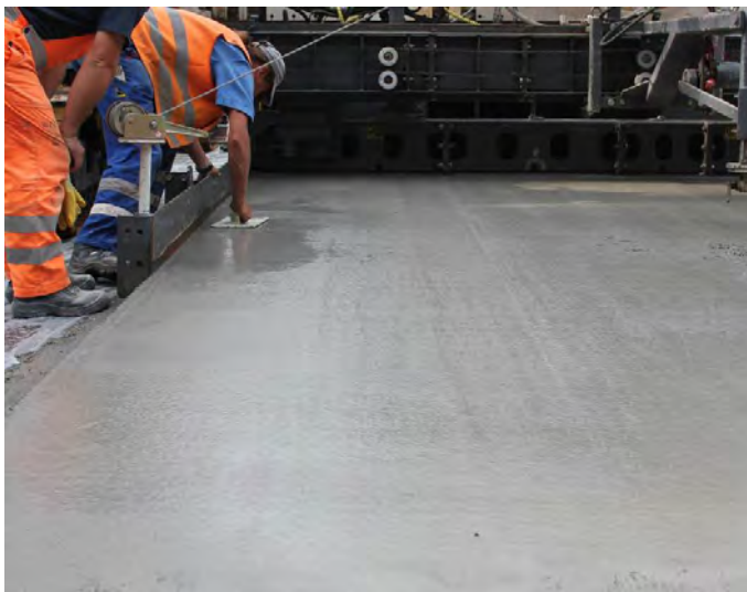
Bild 6: Links: Einbau einer 10 cm dicken Schicht aus UHPC mittels konventionellem Gleitschalungsfertiger; Rechts: aus der Fläche entnommener Bohrkern
