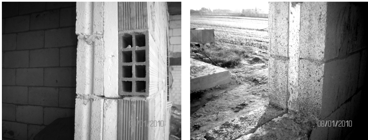
Abbildung 1: Zweischaliges Mauerwerk gedämmt mit Polystyrol-Platten
