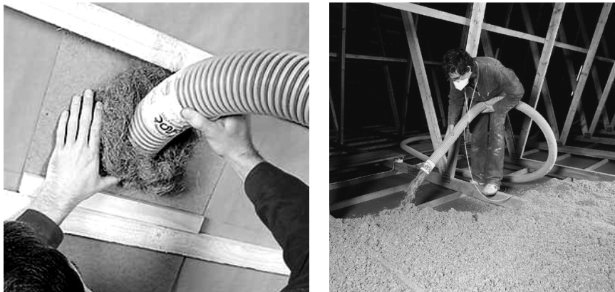
Abbildung 10: Links AP-Einblasen, Rechts AP-Aufblasen, Quelle: isofloc GmbH, www.isofloc.de
