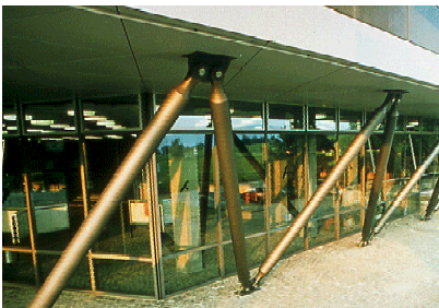
Bild 39: Die neuen Stützen fügen sich ästhetisch befriedigend in das bestehende Gebäude ein
