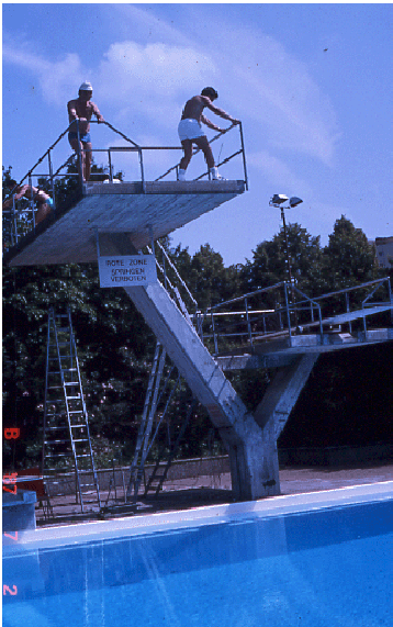
Bild 14: Sprungturm aus Stahlbeton mit starken vor allem horizontalen Schwingungen und breiten Rissen
