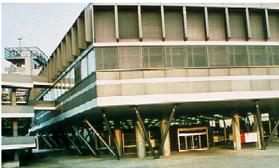
Bild 38: Erdbebenertüchtigung eines Hörsaal- gebäudes der ETH Zürich im Campus Hönggerberg durch Ergänzung der stark exzentrischen Aussteifung durch ein Fachwerk
