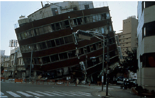
Bild 20: Dieses Gebäude hat sich um die stark exzentrische Aussteifung des Erdgeschosses verdreht, und die vorderen Stützen sind eingeknickt
