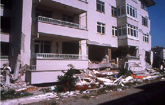
Bild 19: Hier ist ein sogenanntes weiches Erdgeschoss verschwunden; die dortigen Stützen sind noch sichtbar
