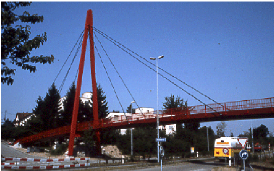
Bild 17: Schlanke Schrägkabelbrücke aus Stahl mit von Anfang an eingeplantem Tilger
