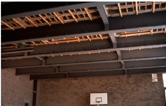
Bild 6: Zwischendecke einer doppelstöckigen Turnhalle mit Schwingungssanierung durch den Einbau eines Stahlträgerrostes
