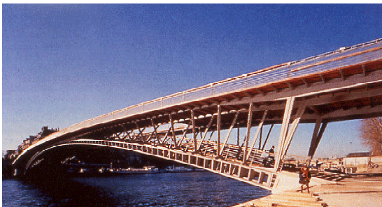
Bild 13: Eröffnete und wieder geschlossene Passerelle Solferino über die Seine in Paris mit starken horizontalen Schwingungen
