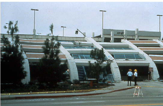
Bild 21: Nach Versagen der inneren Stützen wurde der Fassadenrahmen nach innen gezogen
