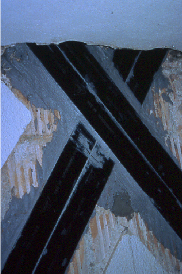
Bild 42: Nahaufnahme einer Kreuzungsstelle der Lamellen
