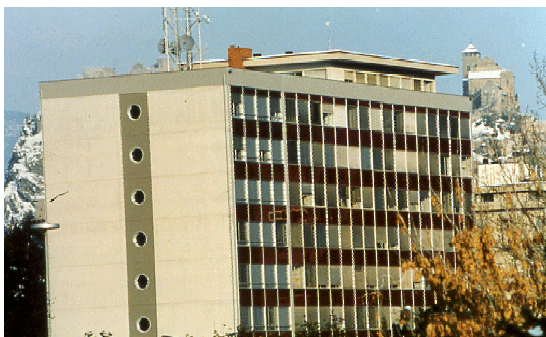
Bild 35: Ertüchtigung des Polizei- gebäudes in Sitten im Kanton Wallis durch Stabilisierung des bestehenden Teils (rechts) durch Anbau eines neuen, rund 9 m langen Teils (links)
