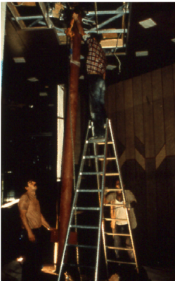
Bild 8: Schwingungssanierung der Decke unter dem Gesellschaftssaal durch Einbau von Stützen in mühsamer Handarbeit
