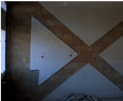
Bild 41: Gebäudestirnwand mit frei gelegtem Mauerwerk für das Aufkleben von fachwerkartig angeordneten Kohlefaser- lamellen
