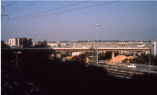
Bild 9: Fußgängerbrücke mit starken Schwingungen horizontal quer zur Brückenachse
