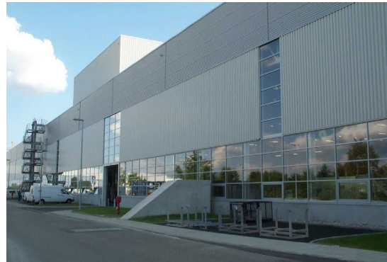
Bild 6: Karosserierohbau Nord N59
