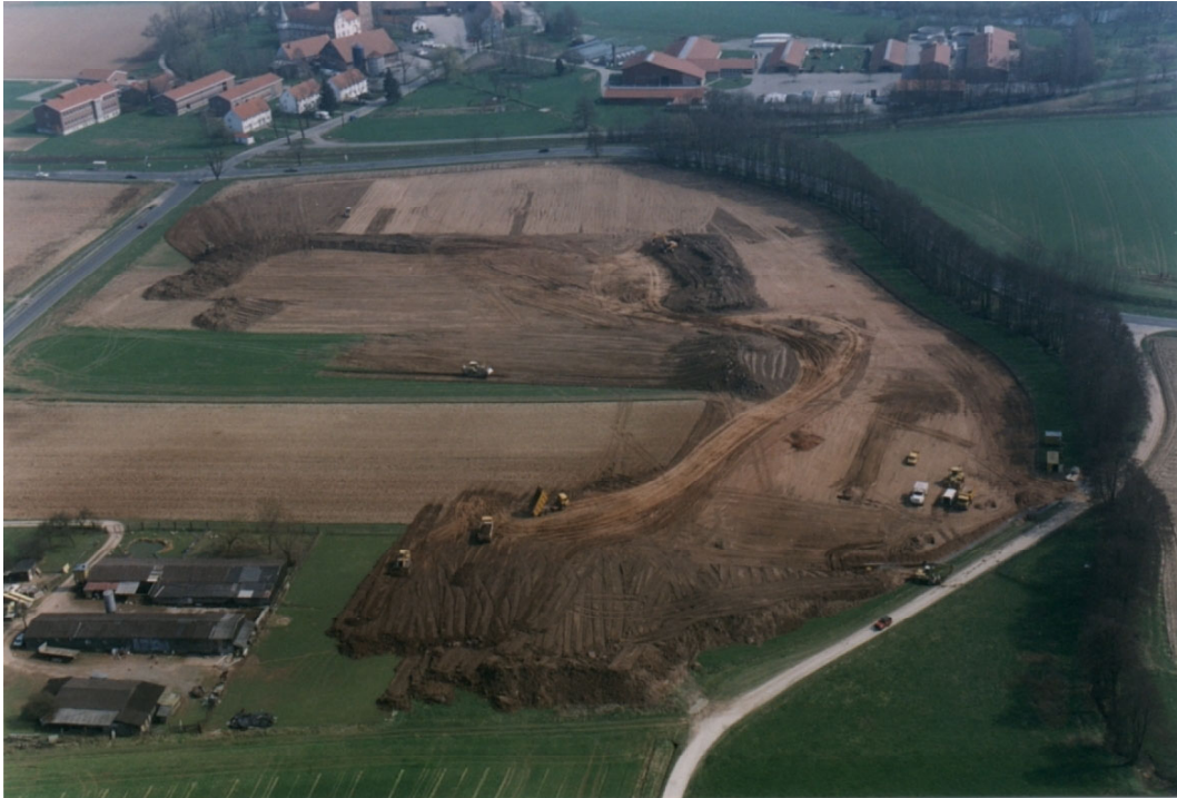
Bild 6: Grundstück Eichhof (Bad Hersfeld)
