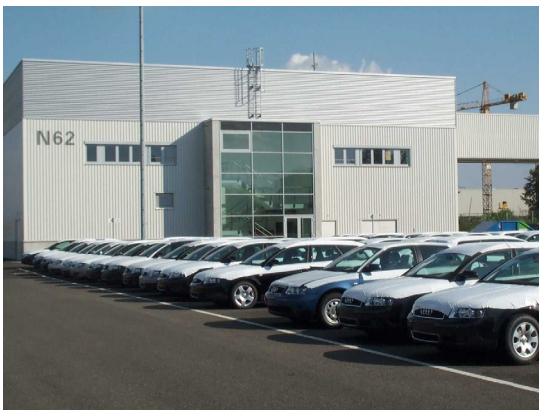
Bild 7: Energiezentrale Nord N62
