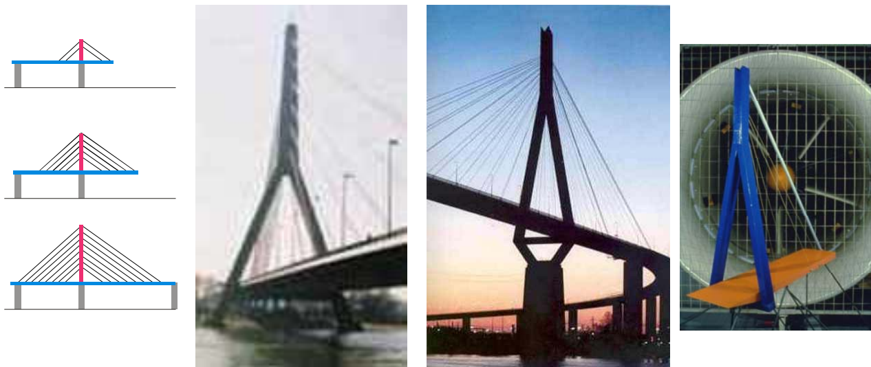
Abb. 8: (von links:) Montageprinzip für Schrägseilbrücken; Schrägseilbrücken in Düsseldorf- Flehe und Hamburg- Köhlbrand (Leonhard); Modellierung des Pylons der Köhlbrand- Brücke für Windkanaluntersuchungen
