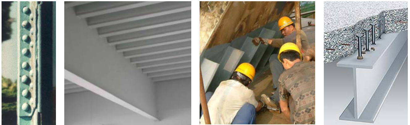
Abb. 9: Verbindungstechniken im Brückenbau nach ihrer zeitlichen Entwicklung Von links: Nieten, Schweißen, HV Schrauben, Kopfbolzendübel. (Gezeigt sind Monteure beim Spannen von HV- Schrauben am Stoß nach Bild 3)
