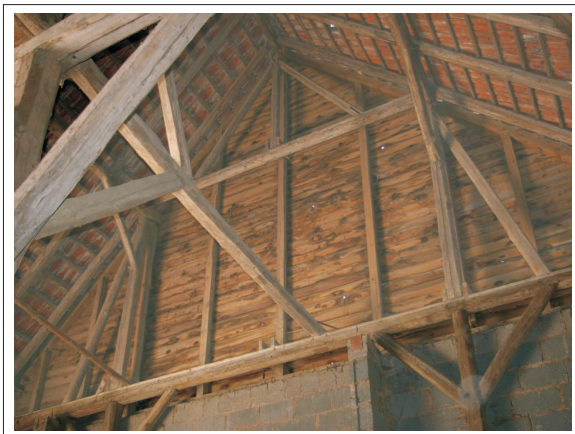
Abb. 1.1. Dachkonstruktion einer alten Scheune ausgebildet als Fach- und Ständerwerk.
