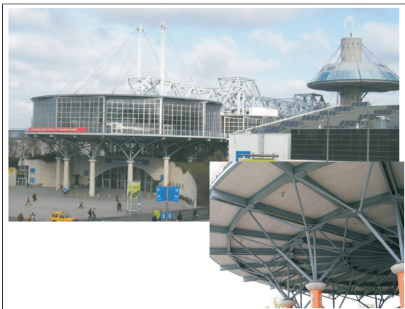
Abb. 1.3. Mehretages Congress-Centrum auf der Hannovermesse. Stahl- und Betonkonstruktion.
