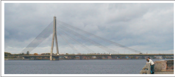
Abb. 1.4. Schrägseilbrücke Vanšu tilts über die Daugawa in Riga/ Lettland.
